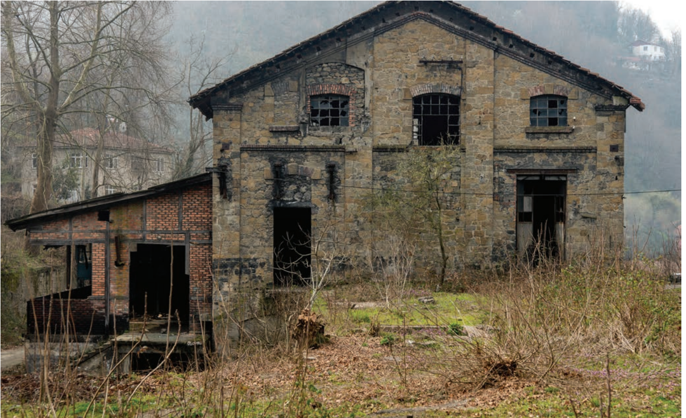
Üzülmez Lavuarı, Zonguldak Merkez
