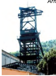
Üzülmaz Taşkömürü İşletme Müessesesi
