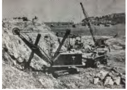
Yeni Zonguldak Limanı İnşaatı
