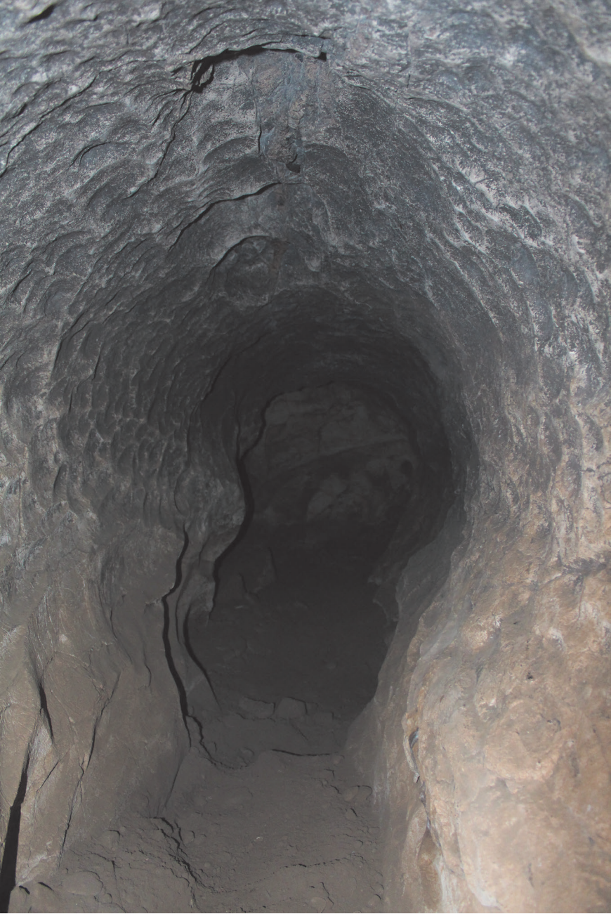
Fotoğraf 203. Kilit tünel (lock tunnel).
