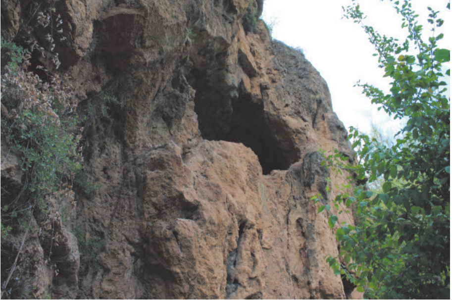
Fotoğraf 34. Mağara girişinin üst kotunda küçük girintiler meydana gelmiştir.
