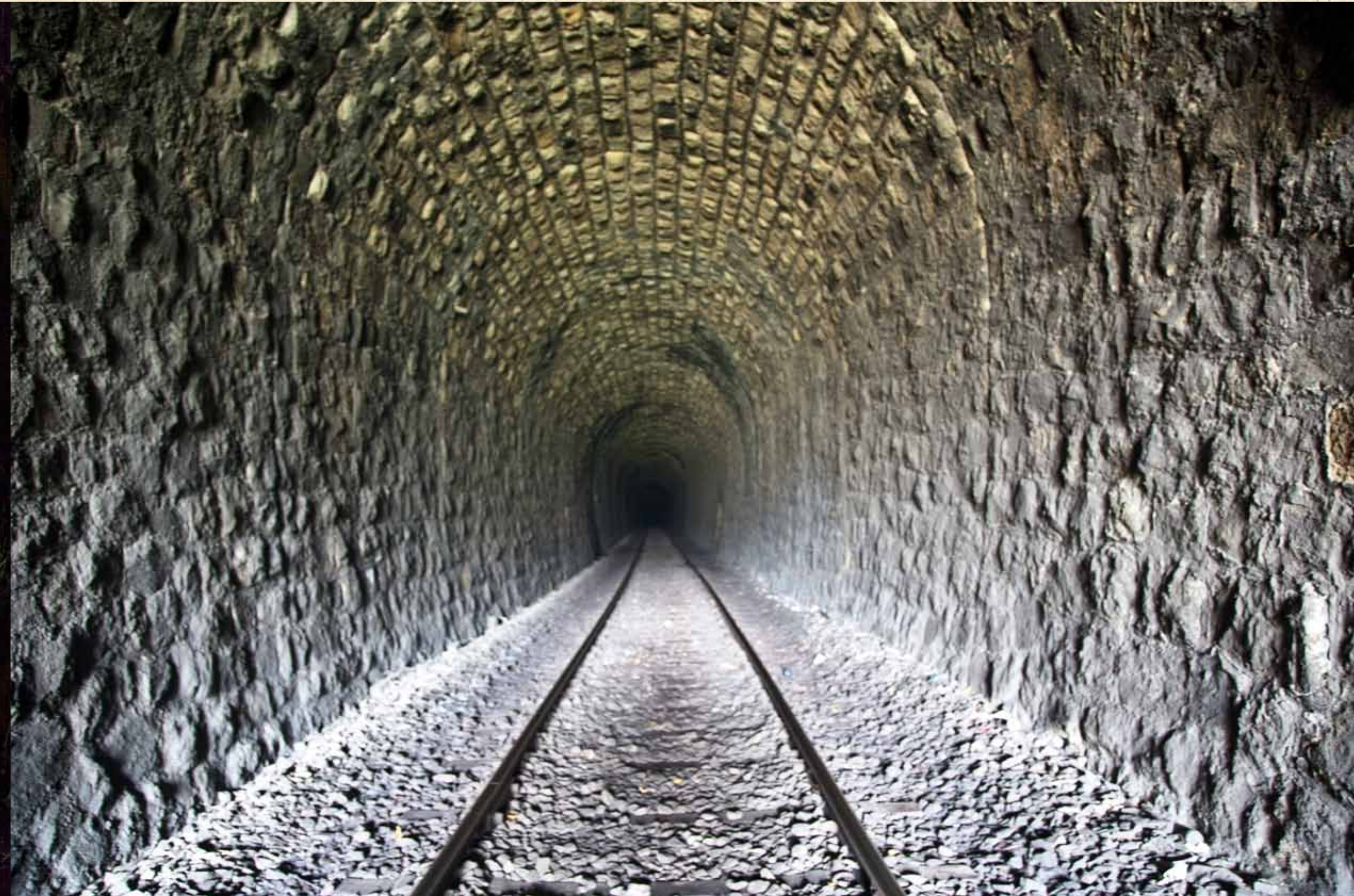
Kozlu-Üzülmez Tren Yolu Tünelleri
