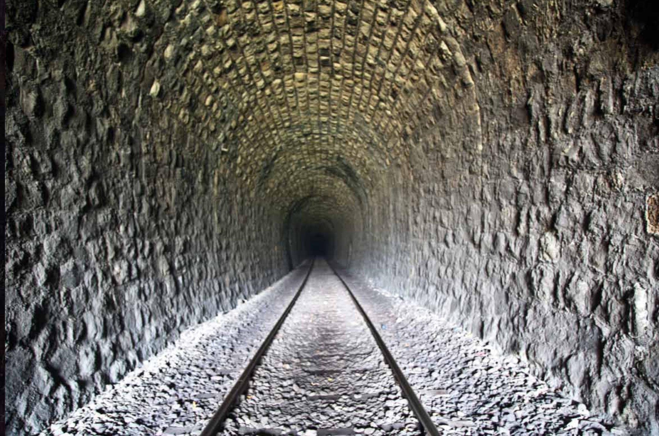
Kozlu-Üzülmez Tren Yolu Tünelleri
