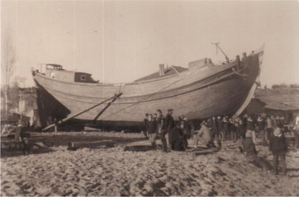
Şekil 3: Kurucaşile'de üretilen "Çektirme" tipi yük teknesi
