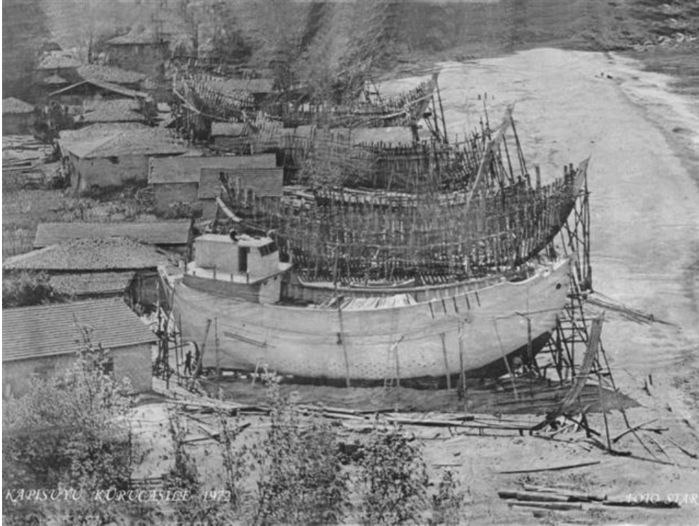
Şekil 5: 1972 yılında Kapısuyu Köyü sahilinde inşa halinde çektirmeler
