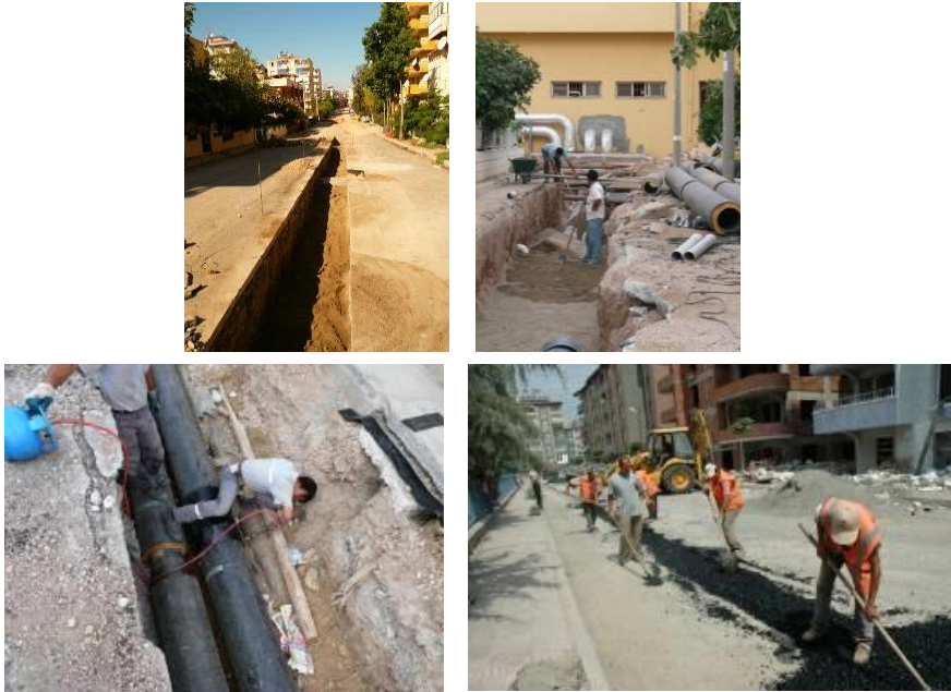
Şekil 7.11. Kanallarının Kazılması, Boruların Döşenmesi ve Montajı, Kanalın Asfaltlanması
