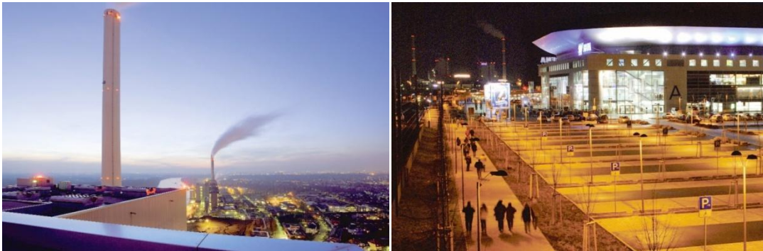
Şekil 3.5 Mannheim Şehri ve Termik Santrali
