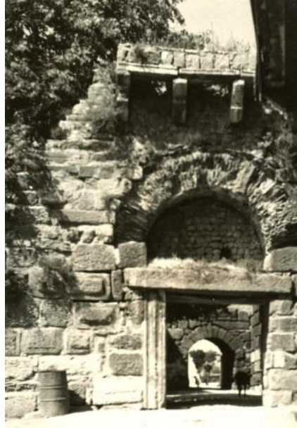
Amasra Kalesi’nin iç içe kapıları (1961).
