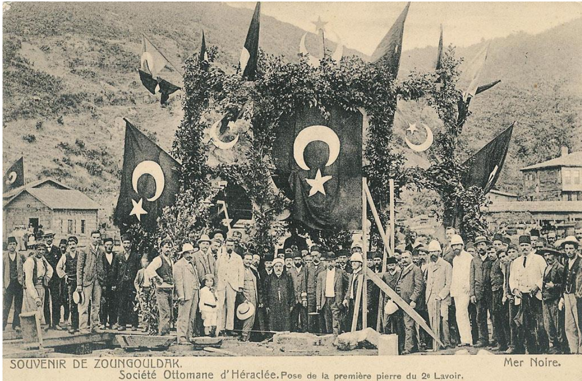
Zonguldak'ta bir "lavuar (k m r yıkama tesisi)" a ılışı.
