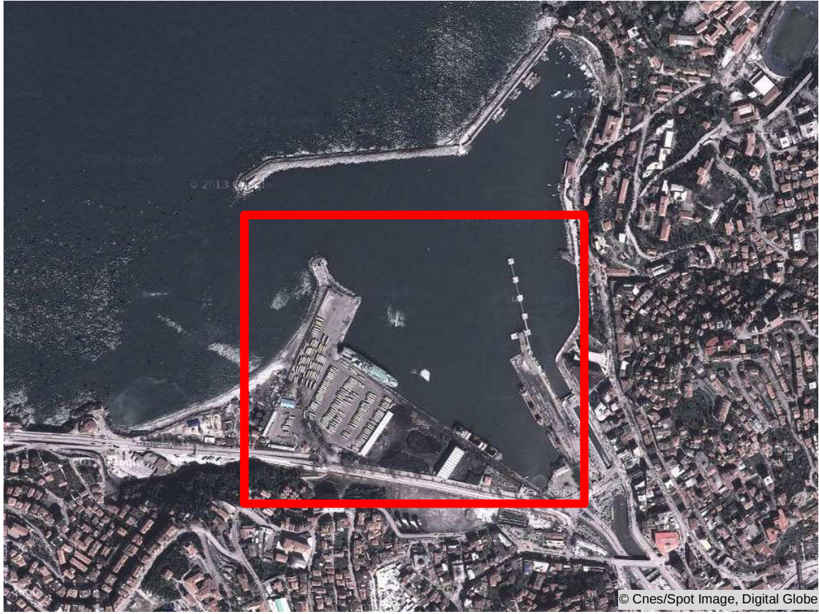
Şekil 26: Zonguldak Limanı, Ro-Ro Rıhtımı ve TIR Parkı
