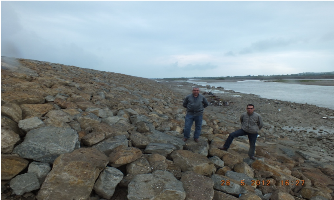
Şekil 10.1 Filyos Seddeleme Çalışması
