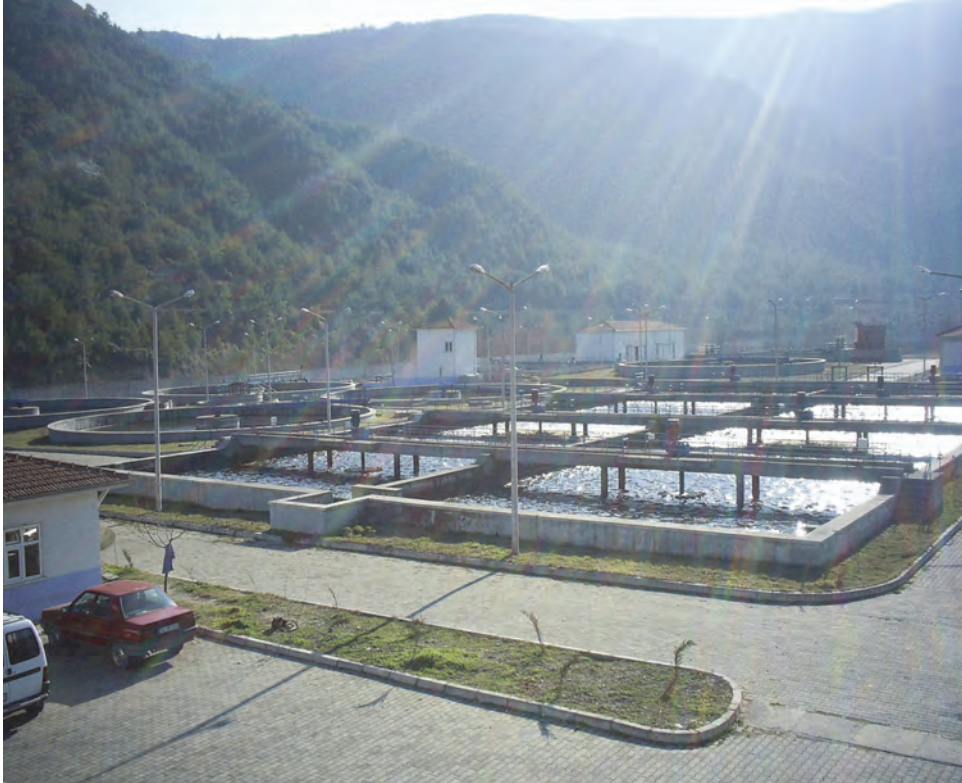
Şekil A2.2a Karabük İli Evsel Atıksu Arıtma Tesisi Görüntüleri
